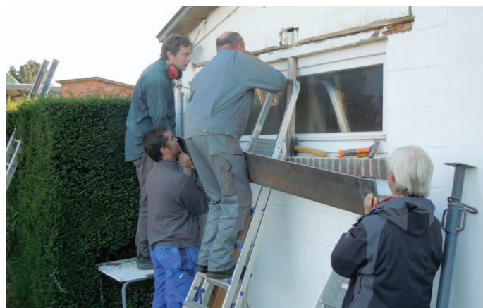
De urinoirs werden vervangen, en een nieuwe latei werd geplaatst boven het WC-venster...
